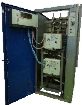
Камера сборная одностороннего обслуживания КСО со схемами первичных цепей, переменного трехфазного тока частотой 50 Гц и напряжением 10(6)кВ с изолированной нейтралью. Предназначены для реверсного управления нагрузкой.
